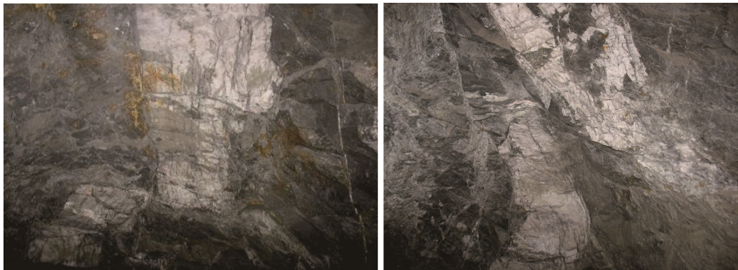
25 中段 103 线附近, 巷道顶部的照片, 镜头向南向上, 灰白色是石英脉, 灰黑色是千枚岩。两照片分别属于两条断层, 断距约 0.5~1 m, 左行扭动, 断层面波状变化。左图断层局部产状 330° 58°, 右图断层局部产状 300° 45°。
